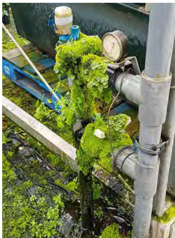
Les fuites présentes dans le système d'irrigation doivent être réparées. De toute évidence, la fuite ici n'a pas été colmatée depuis longtemps...
